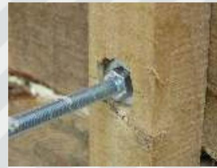
Шпилька Усиленная способна выдерживать повышенные статические и динамические нагрузки, и может быть использована для сборки конструкций опалубки при возведении фундаментов и монолитном домостроении.
